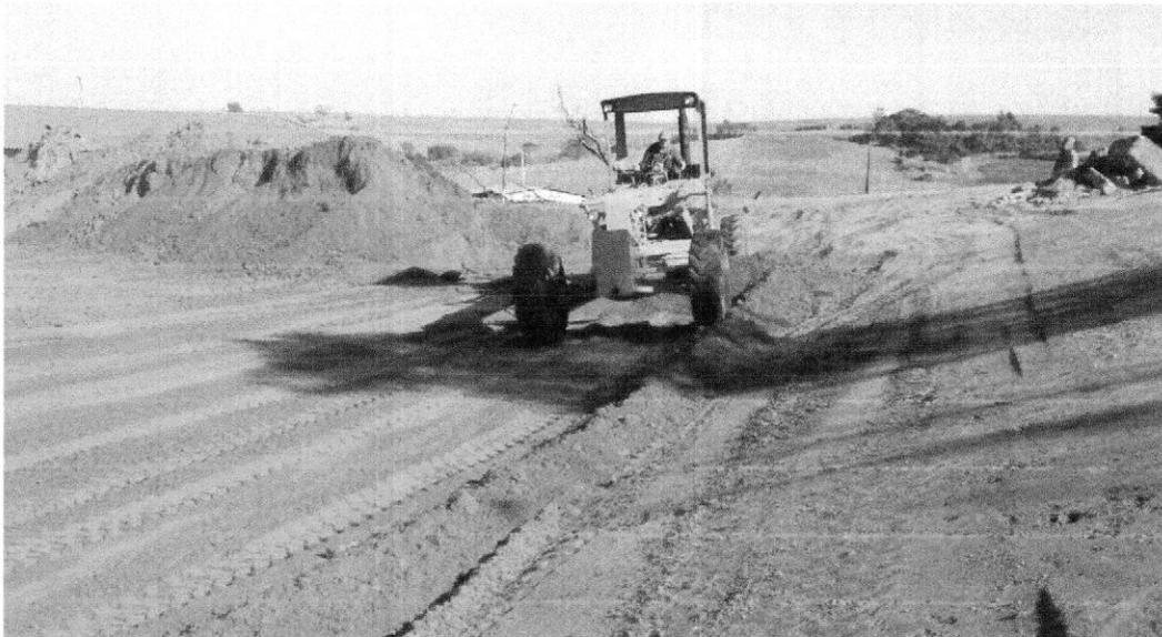
Figura 15. Sistema de compactação de fundo com argila
